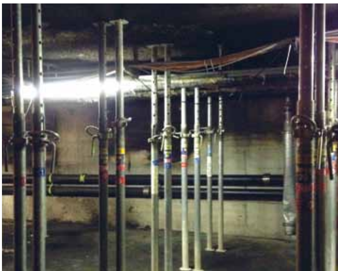
Stahlstützen zur Einsturzicherung der Decke nach dem Brand
