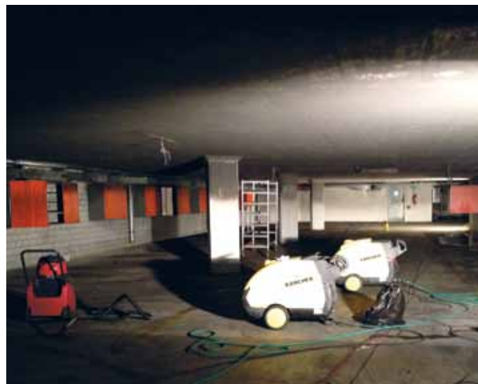
Reinigungsarbeiten in der Tiefgarage nach dem Brand
